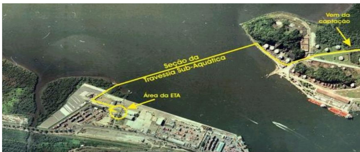
Foto 2 – Caminhamento da adutora de água bruta
